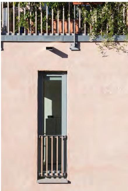
**Bild 6.** Die handwerklich ausgeführten Putzflächen und -kanten ohne Schienen geben dem Gebäude einen plastischen und körperhaften Charakter
