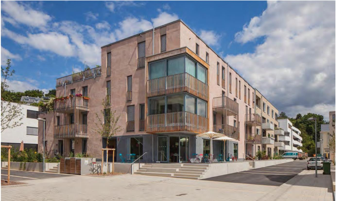
**Bild 1.** Das Baugruppenhaus „en famille“ in Tübingen steht zum Schutz vor Hochwasser erhöht auf einem Sockel und weist mit einer markanten Ecke auf den Egeriaplatz
